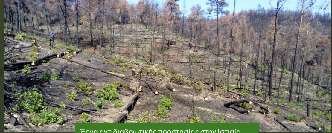
Έργα αντιδιαβρωτικής προστασίας στην Ιστιαία
