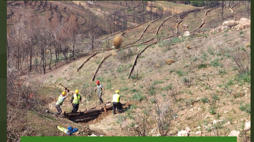
Έργα αντιδιαβρωτικής προστασίας στον Βαρνάβα
