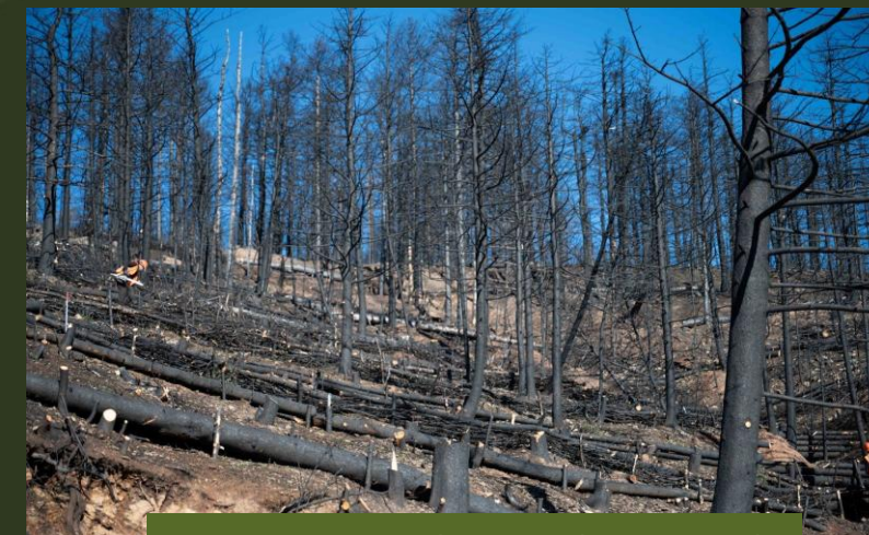
Έργα αντιδιαβρωτικής προστασίας στον Φενεό
