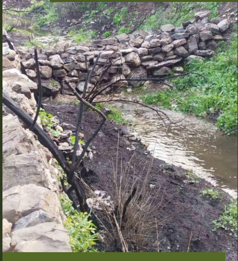
Έργα αντιδιαβρωτικής προστασίας με λιθόκτιστες κατασκευές σε ρέματα στα Κύθηρα
