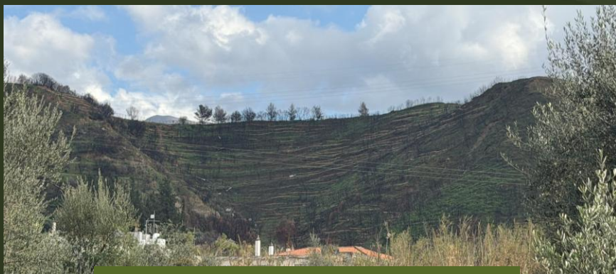
Έργα αντιδιαβρωτικής προστασίας στην Αχαΐα
