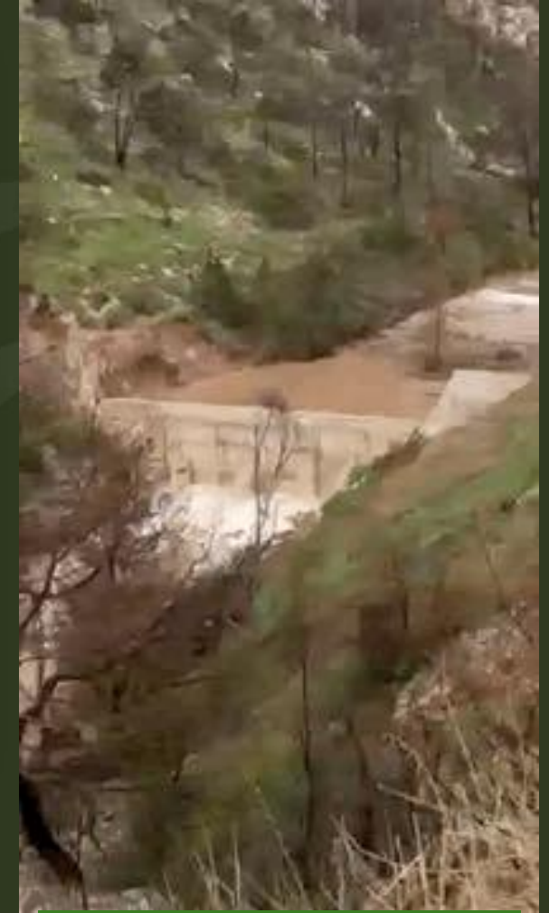
Ορεινά Υδρονομικά έργα στην Πάρνηθα
