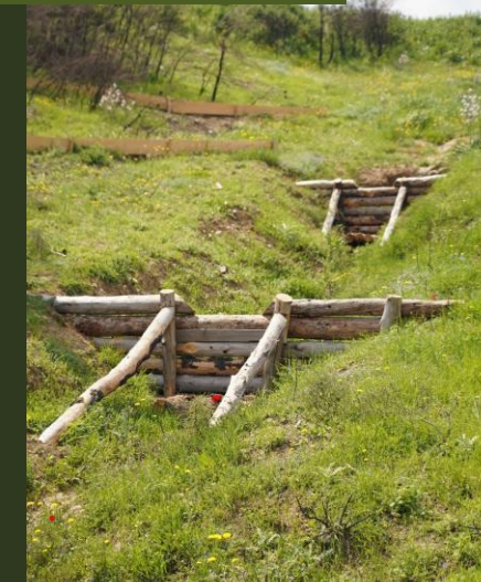
Έργα αντιδιαβρωτικής προστασίας στο Κρυονέρι
