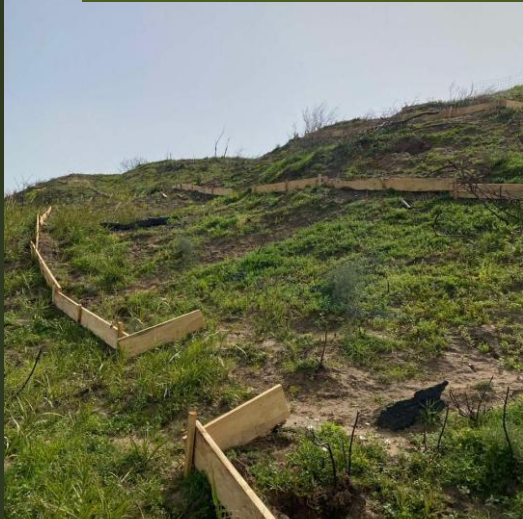
Έργα αντιδιαβρωτικής προστασίας στην Ηλεία
